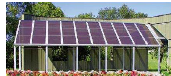
ESEMPIO DI APPLICAZIONE DEL PANNELLO TRASPARENTE FOTOVOLTAICO SU SERRA
