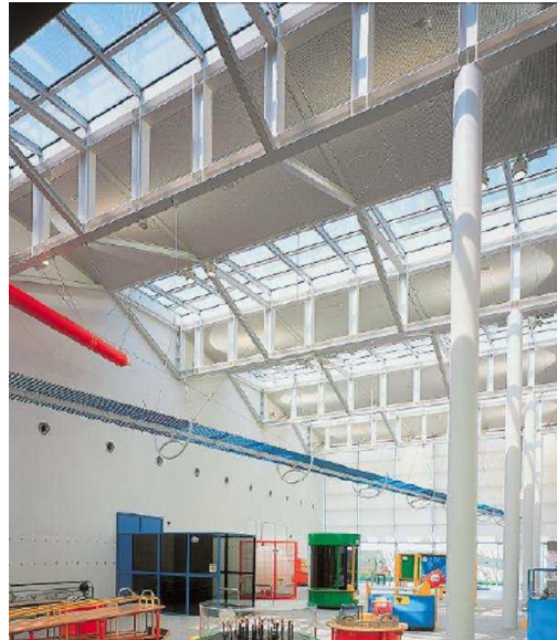
ESEMPIO DI APPLICAZIONE DEL PANNELLO TRASPARENTE FOTOVOLTAICO IN COPERTURA SU TETTI SCHED
